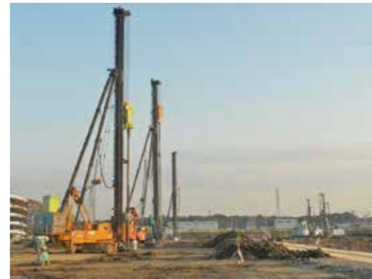
大型施工機械を複数投入し、短い工期での施工を実現
