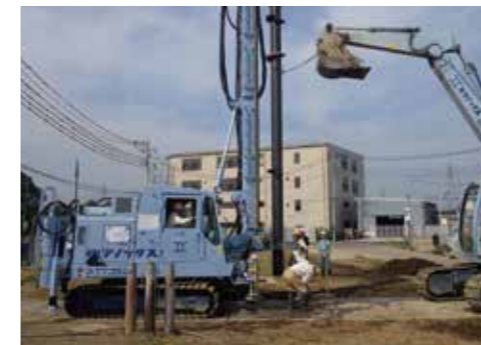
⑤羽根付き鋼管の建て込み
