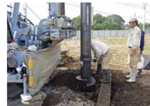
⑦羽根付き鋼管の接続(機械式継手)
