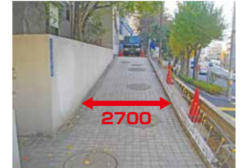
通路幅 2.7m を重機自走させて搬入しました。
