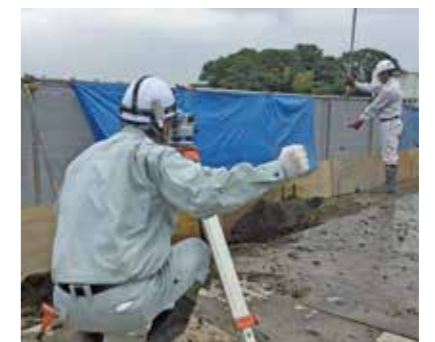
⑧杭頭レベル確認
